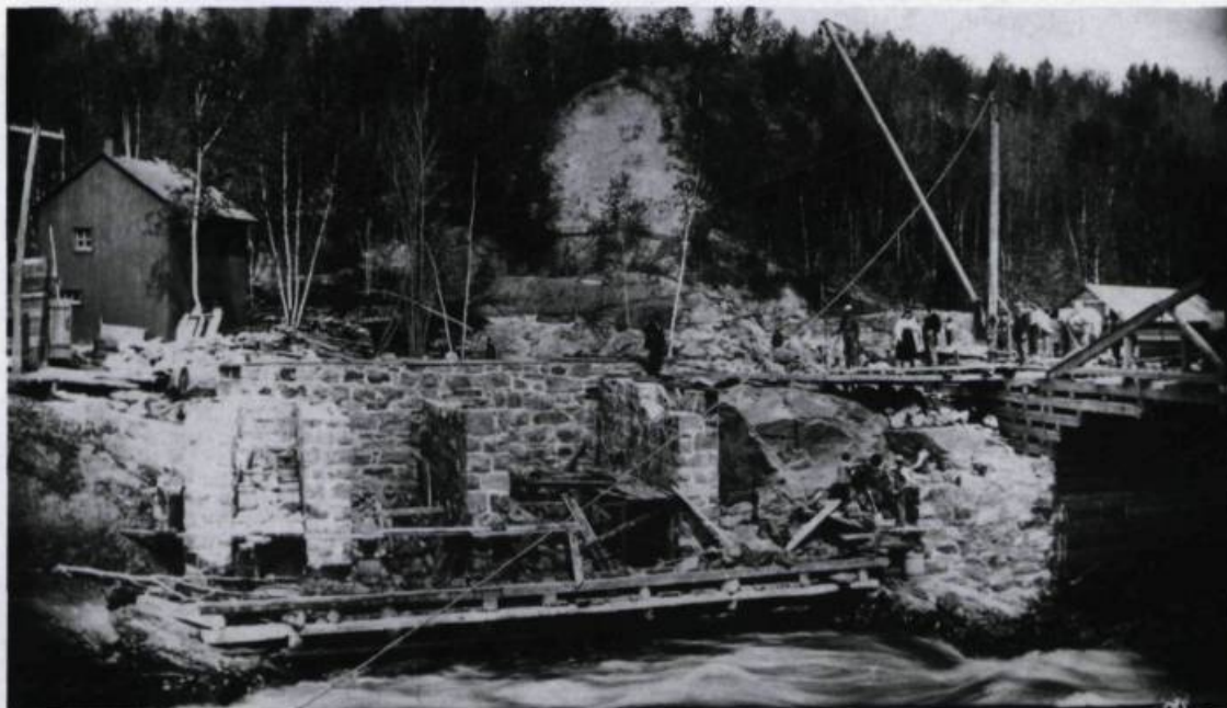
Le site de «l'île électrique» à Chicoutimi vers 1897. En avant-plan, la construction du premier moulin de la Pulperie de Chicoutimi. Œuvre de l'architecte C.E. Eaton et de l'ingénieur Alex Wendler, son aménagement coûtera 125 000 $ et 75 employés seront affectés à la production. En arrière-plan, à gauche, la petite centrale de la Compagnie électrique de Chicoutimi.
