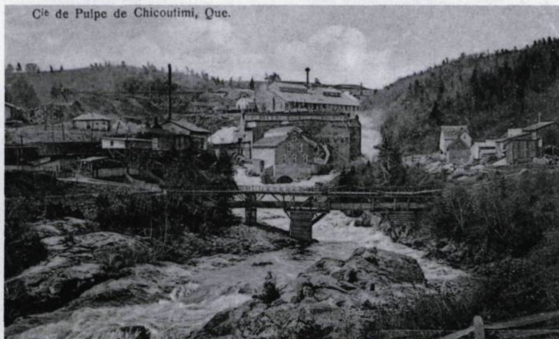
Carte postale de Novelty Manufacturing and Art Ltd de Montréal montrant le site de la Pulperie de Chicoutimi vers 1915. En avant-plan, le long de la rivière Chicoutimi, les trois moulins, le quatrième étant construit en 1919-1920. À gauche de la photo, le hangar à locomotive, le bureau administratif et l'atelier mécanique. (Collection privée).
