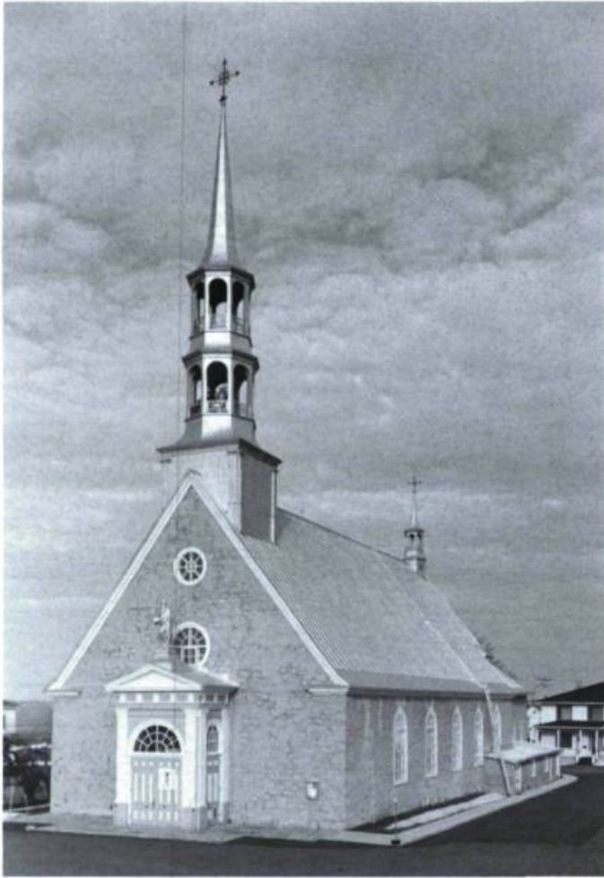
Le volume très simple du carré et le toit muni de larmiers n'ont pas changé depuis la construction. Photo: Jacques Beardsell, Service canadien des parcs.
