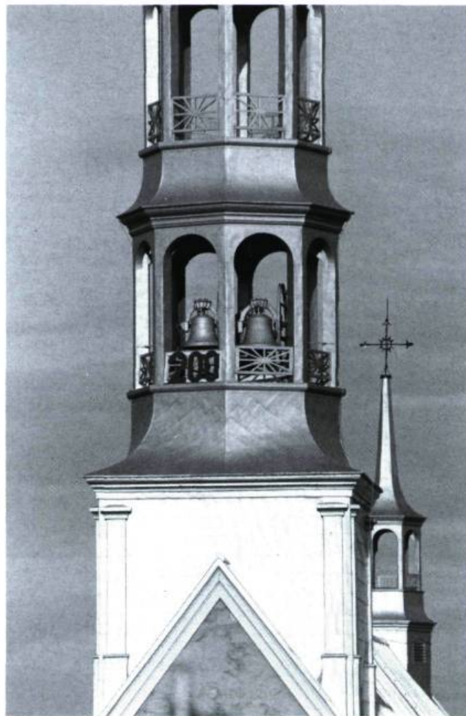
Liaison de la base carrée et du lanternon inférieur du clocher. Photo: Jacques Beardsell, Service canadien des parcs.
