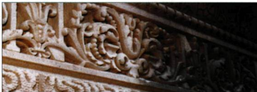
Détail de sculpture nettoyée par moitié selon le procédé de gommage® Thomann-Hanry® : l'architecture est préservée. Photo : Michel Calmon
