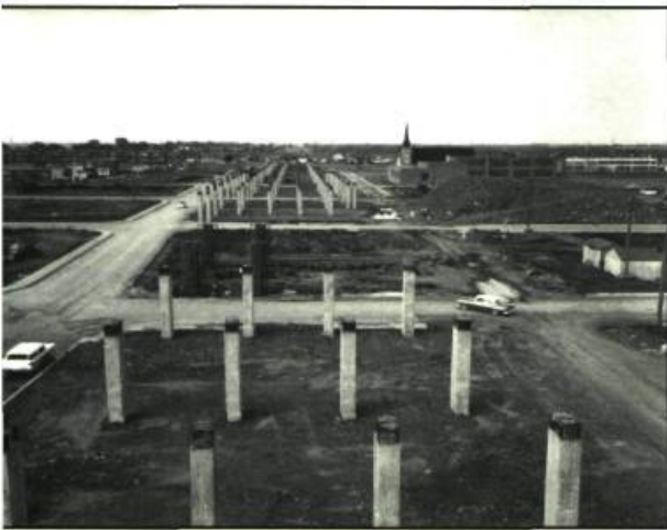
Le boulevard Métropolitain en construction Photographe inconnu Vers 1958 Épreuve argentine à la gélatine Fonds Studio O. Allard Photographes Inc. Archives Nationales du Québec © Janin Atlas Inc.
