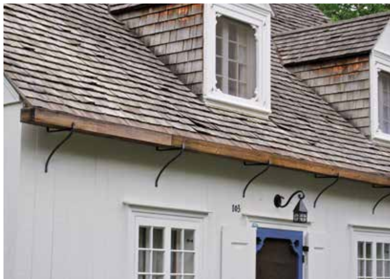
Des solives de bois ou, comme c'est le cas ici, du fer forgé supportaient les gouttières de bois.
