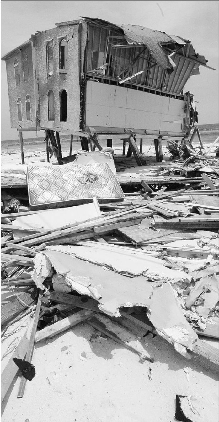
Dégâts causés par l'ouragan Dennis en Floride en 2005. Wikipédia en français
