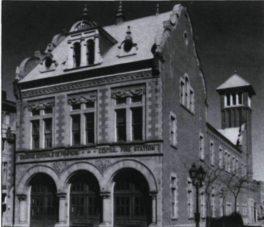
Le Centre d'histoire de Montréal loge dans l'ancienne caserne de pompiers construite en 1903, place d'Youville, au cœur même du Vieux-Montréal. (Archives du Centre d'histoire de Montréal).
