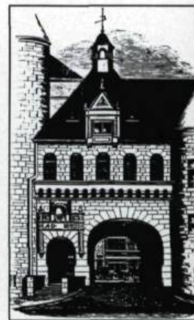
Entrée principale du Château Frontenac en 1892. Lors de la construction de cette porte cochère l'architecte intégra dans la structure une pierre ancienne montrant la croix de Malte. Ce vestige de 1647 rappelle le souvenir du gouverneur Charles Huault de Montmagny. (The Morning Chronicle, 17 décembre 1894).
