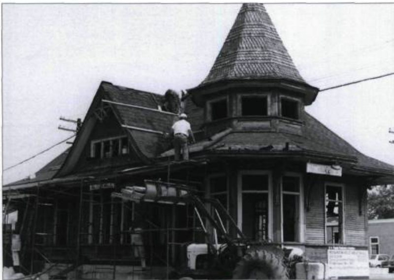
La gare en voie de rénovation à l'été 1983. (Archives de la Société de la gare, Acton Vale).
