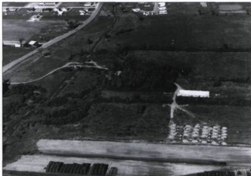
«Commencement des travaux sur le site original, juillet 1961». En 1961, le musée commence à sortir de terre au milieu des champs et des bois. Trente-sept ans plus tard, il compte deux hangars, un centre d'archives, un atelier, et plus de 75 acres de terrain. (Archives de l'Association canadienne d'histoire ferroviaire).
