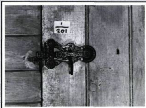
Loquet complet trouvé en place à la maison Saint-Laurent. Il s'agit d'un objet usiné, en fonte, à motifs décoratifs.
