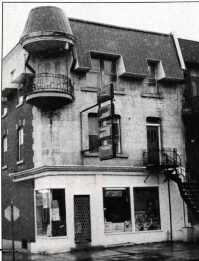
Un exemple éloquent de mauvaise rénovation à Montréal. (photo: M. London)
