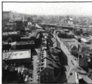
5. Les «Nouvelles casernes». Ce bâtiment militaire datant de 1749, long de 525 pieds et situé au coin des rues Côte du Palais et de l'Arsenal dans le Vieux-Québec, a fait l'objet d'un curetage important en 1975. (photo: Parcs Canada)
