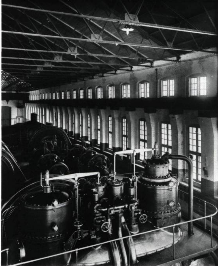
L'usine de filtration d'eau à Shawinigan au début du siècle photographiée par le Studio Notman & Son. Pour cette structure moderne très typique de la révolution industrielle où s'exprime la confrontation de l'homme et de la machine, l'image est beaucoup plus stylisée; le photographe prend position face aux jeux de formes, d'angles et de volumes. (photo: Archives photographiques Notman, Musée McCord)
