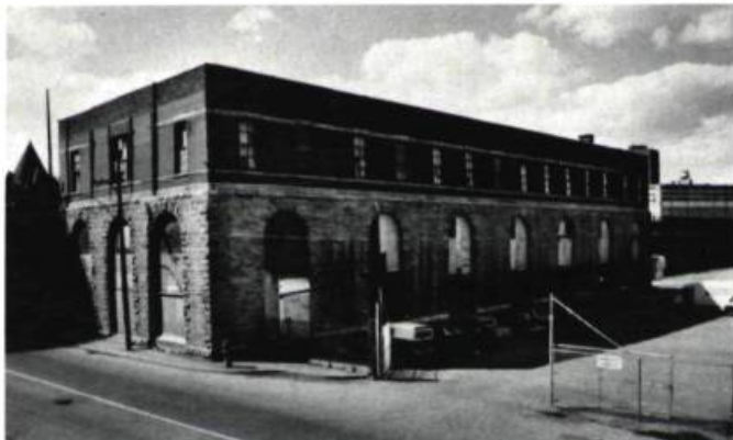
La gare Dalhousie, dans le secteur est du Vieux-Montréal, avant sa restauration. Vue de la cour. (photo: Héritage Montréal)
