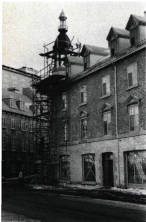
Rue Saint-Paul, dans le Vieux-Québec, une partie de la façade des Maisons Lecourt, en voie de restauration. En arrière-plan, l'îlot Saint-Nicolas, récemment rénové. (photo: G. Leahy)
