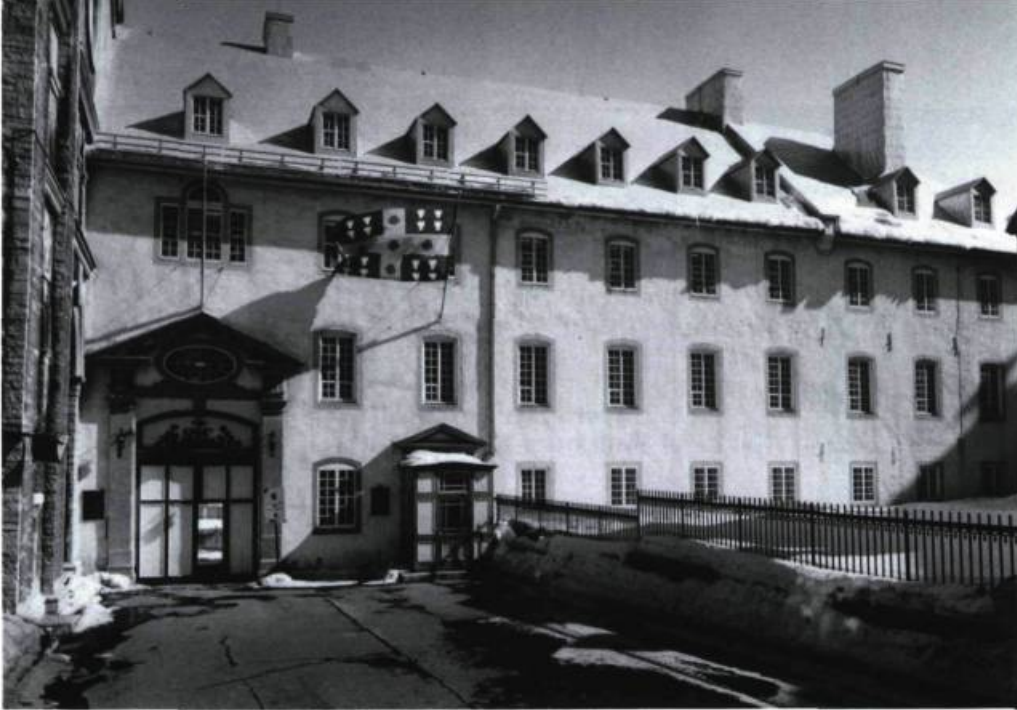
La façade du Séminaire, sur la côte de la Fabrique, fait partie de l'aile de la Congrégation construite par Thomas Baillairgé de 1822 à 1830. Le revêtement de la toiture, en fer-blanc non peint, vient d'être refait. (photo: B. Ostiguy)
