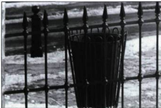
Clôture contemporaine au Parc de l'Artillerie à Québec. Les traverses et les poteaux sont faits d'acier alors que les épis de couronnement et les noeuds sont moulés en fonte. (photo: Service canadien des parcs)
