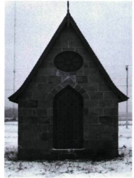
L'ancienne poudrière, un des bâtiments qui a échappé à l'incendie de 1964. (photos: Émile Gilbert, architecte)
