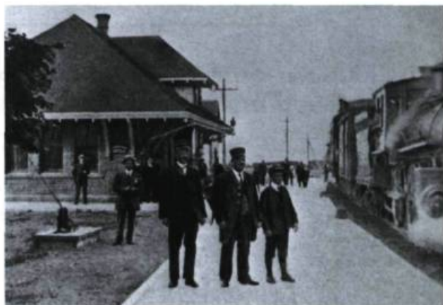
La gare de l'Intercolonial à la fin du siècle dernier.
