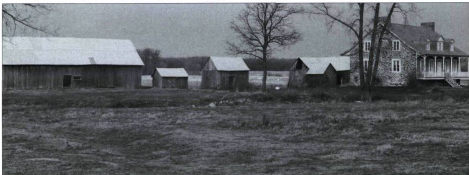
Construite autour des années 1845, la maison Leblanc à Saint-Grégoire en Mauricie représente le produit de la mutation de la maison québécoise avec son rez-de-chaussée surélevé et sa longue galerie en façade couverte par un avant-toit.
