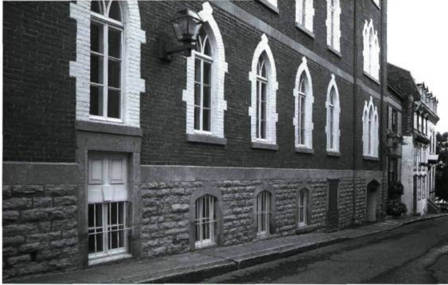
Au premier plan, l'ex-entrée des filles-mères de la Maison Béthanie rue Couillard transformée en fenêtre en 1991. Sur le linteau, on peut lire « Hôpital de la Miséricorde ». Photo : Luc-Antoine Couturier
