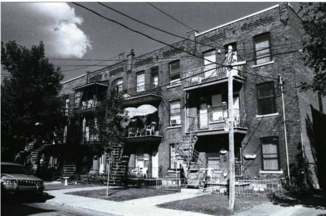
Rue Hall, de véritables triplex datant des premières décennies du XX e siècle, avec un seul logement par étage.
