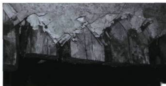
Détail d'un lattage posé de façon croisée avec un revêtement de plâtre recouvert ultérieurement de tapisserie.
