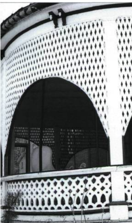
Cette galerie de Waterloo est richement décorée d'un lambrequin en treillis et d'un garde-corps dont les balustres sont découpés en motifs géométriques.
