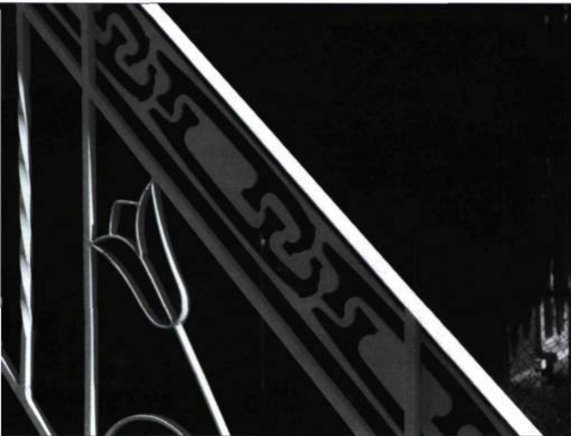
Les garde-corps formés de retailles négatives de lames de patins sont légion dans le quartier Limoilou à Québec.
