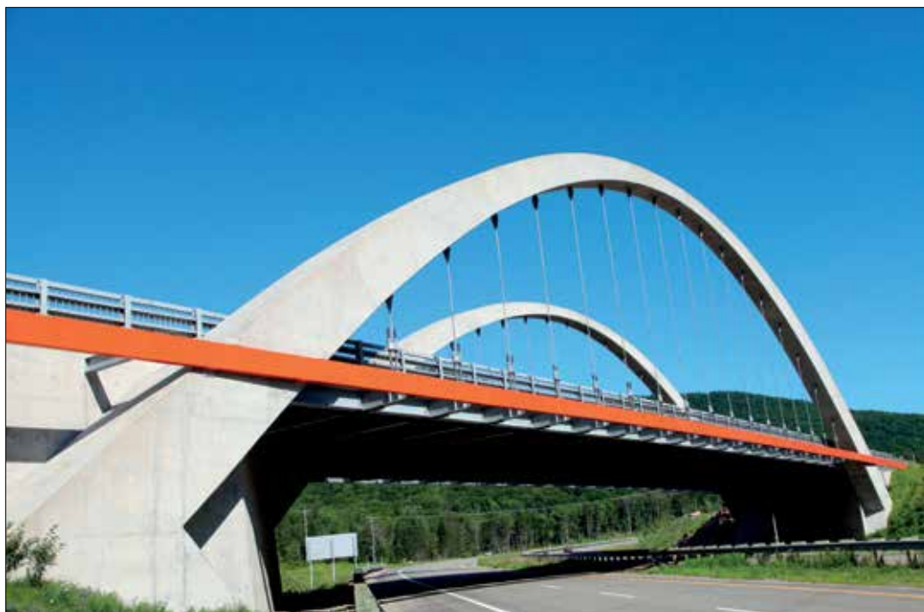
Le béton donne toute son élégance au pont de la route 175, construit à Stoneham en 2011.
