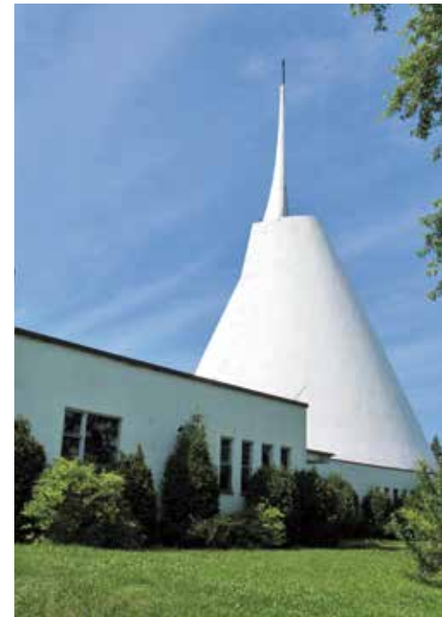
L'église Notre-Dame-de-Fatima à Saguenay et son presbytère. On a « dé-cité » ce lieu de culte afin de permettre sa démolition.
