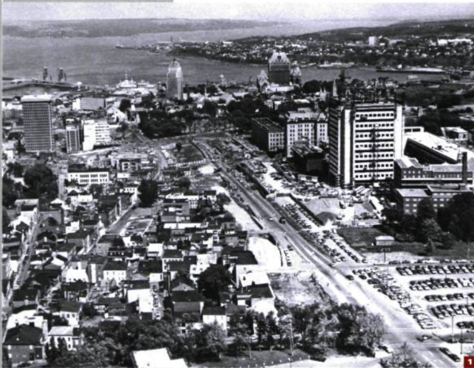
> 1 Vue de la haute-ville de Québec, construction du complexe G, 1969.
