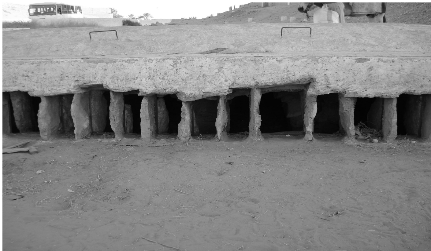
Figure 9. Ouvrage de partage des eaux de crues de la foggara de Mzab (REMINI, 2007). Sharing waters of the flood foggara at Mzab (REMINI, 2007).
