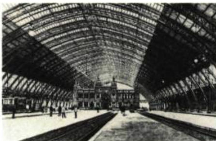
Quais de gare.
