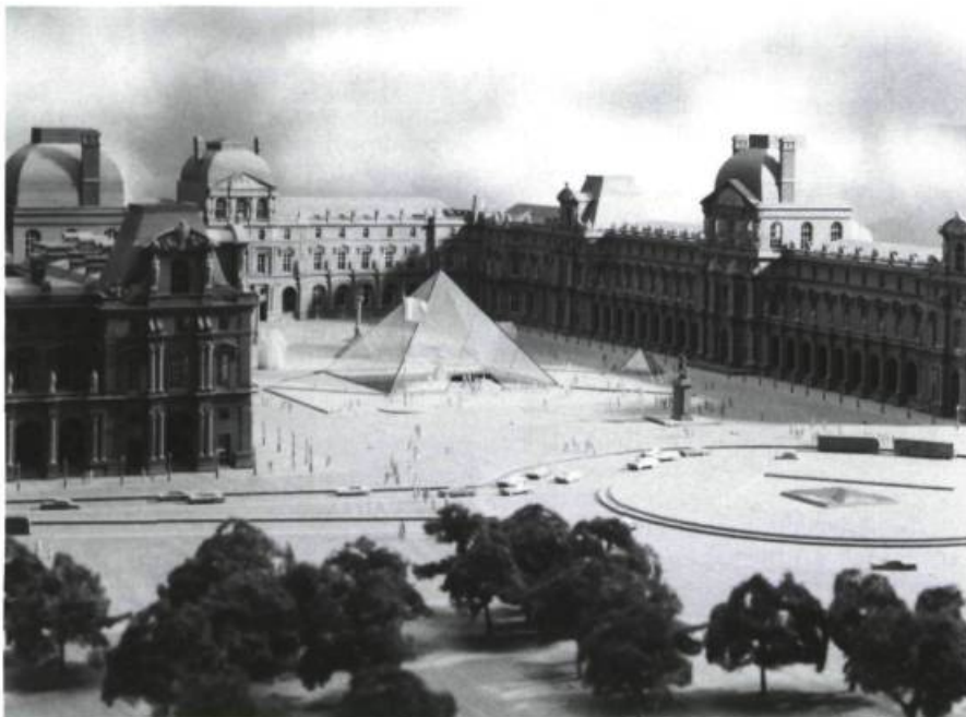
Pyramide du Grand-Louvre en chantier. Mars 1988. (Photo Patrice Astier)
