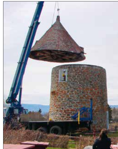
Enlever la toiture à l'aide d'une grue comportait des risques, mais l'opération s'est bien déroulée.
