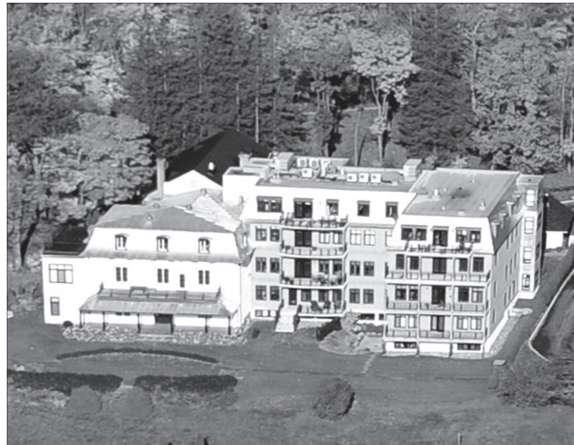
La villa Benmore (1834-1835) a été intégrée à un ensemble architectural lorsque les Sœurs missionnaires Notre-Dame d'Afrique s'y sont installées en 1947.
