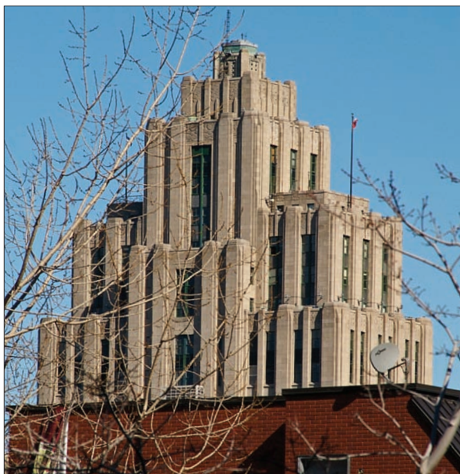
De pur style Art déco, l'édifice Aldred évoque une fontaine figée.
