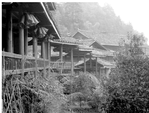
Figure 7 Le centre de ressources écologiques de Dimen
