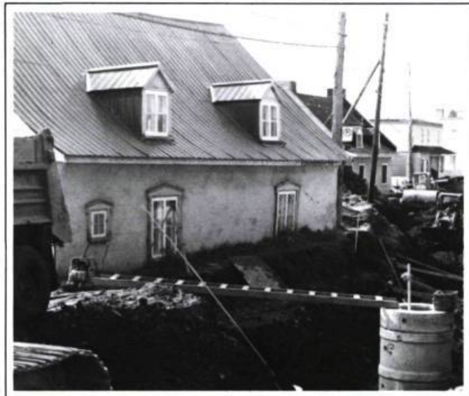
La réfection de l'avenue Royale à Château-Richer, sur la Côte-de-Beaupré. Un exemple d'intervention dans un environnement patrimonial.
