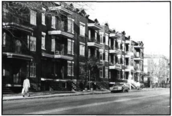
Bâtiments résidentiels qui participent à la remarquable homogénéité du quartier Montcalm. La qualité des logements, leur prix et la qualité de l'environnement concourent à stabiliser la population dans le milieu.
