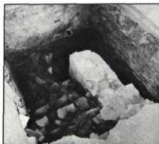
7. Escalier en maçonnerie avec marches en dalles de pierre datant du Régime français, condamné au début du XIX e siècle. Encore une fois le curetage est venu confirmer l'indication donnée par les plans anciens. (photo: Parcs Canada)
