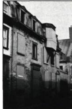
12. Bâtiment d'allure fin de siècle mais dont le curetage révèle l'existence sous-jacente d'un bâtiment construit sous le Régime français. (photo: F. Varin)
