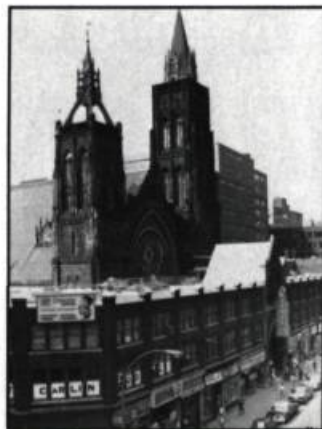
«Le Ministère tend depuis plusieurs années à ne pas déclarer d'aire de protection en milieu urbain. Les abords des édifices classés n'ont donc aucune protection.» Le cas de l'église St-James à Montréal. (photo: Héritage Montréal)
