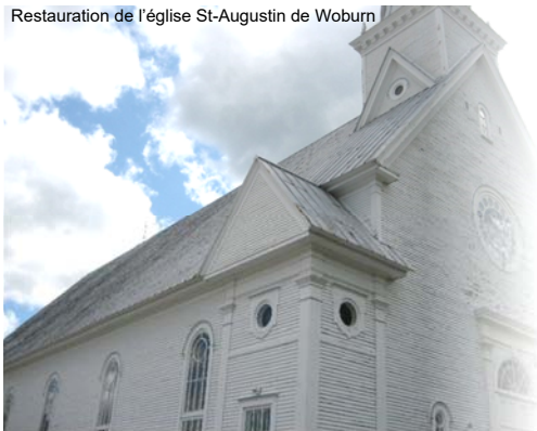
Restauration de l'église St-Augustin de Woburn
