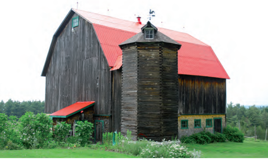
Avec sa silhouette élancée et son silo de bois, cette grange-étable à toit brisé, située à Stanstead-Est, a de quoi attirer le regard. Sa partie étable se distingue par ses fenêtres et un revêtement de bois différent de celui du reste du bâtiment.
