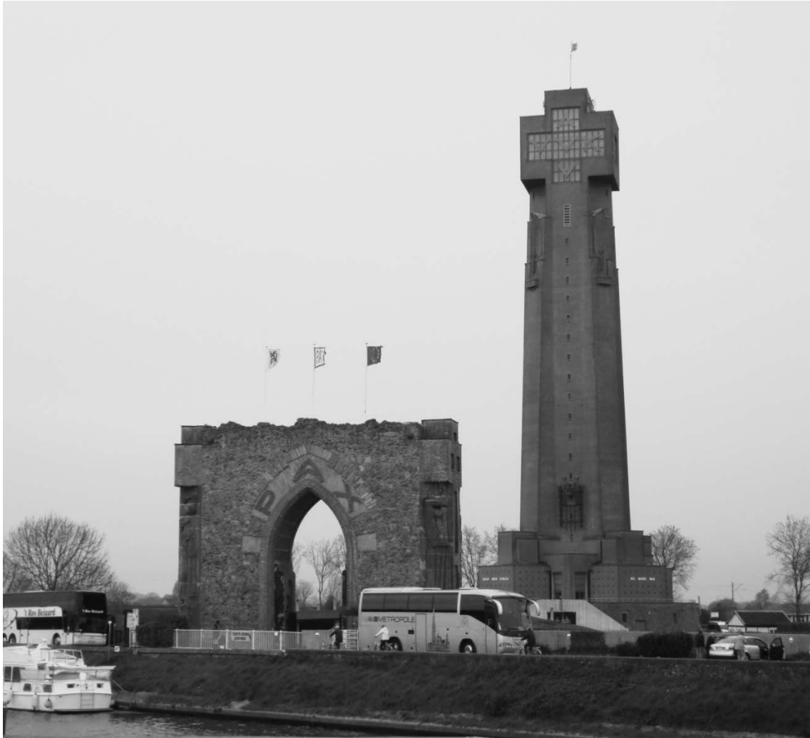
Image 1 : Site de la Tour de l'Yser vue de l'autrerive du fleuve.
