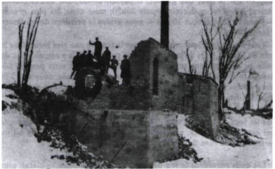
La «marine», une construction de brique sise près de la rivière des Mille-Îles dans laquelle se trouvaient les pompes qui tiraient l'eau de la rivière pour combattre les incendies. Malheureusement, le soir du 1er décembre 1922, on s'aperçut que les appareils ne fonctionnaient pas.
