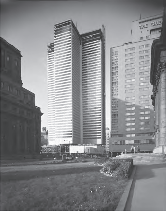
Figure 10: Place Ville-Marie under construction (Archives de Montréal).
