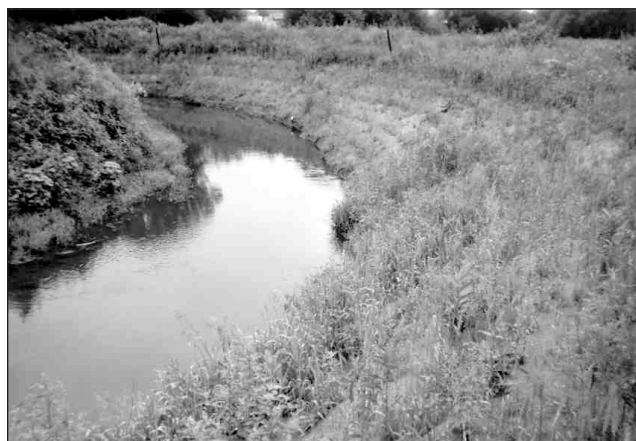
FIGURE 3. Travaux de stabilisation des berges, à l'aide d'un adoucissement de la pente de la berge externe (30°) et de l'ajout de végétation, effectués en juin 2003 au site d'étude (vue vers l'aval).
