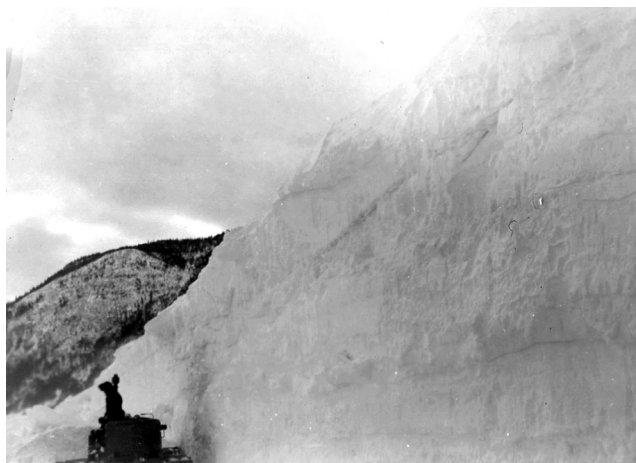
FIGURE 9. L'hiver 1955-1956 se distingue par des chutes de neige bien supérieure à la normale. Une déneigeuse à l'œuvre près du pont de l'Anse-Pleureuse (route nationale 132) à la fin de janvier 1956 (photographie : Ministère des Transports du Québec).
