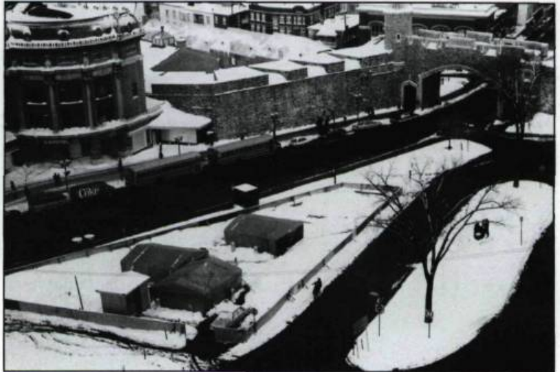
Vue générale du site des fouilles archéologiques. (Ville de Québec, photo: Brigitte Ostiguy).
