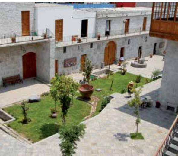
Tambo La Cabezona après restauration
