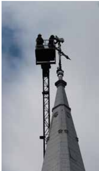
Les travaux ont notamment permis de corriger certaines déficiences du clocher.
